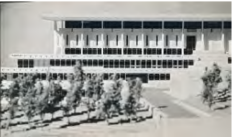
Knesset, zweite Überarbeitung (Modell) mit terrassierten Bürogeschossen und zurückgestellten Stützen, um 1961
