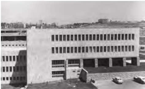
Zustand nach Fertigstellung
